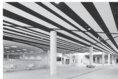
エントランス（1階）
