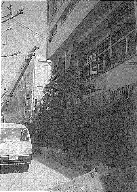
外側より4階建てを鉄支柱がささえている
